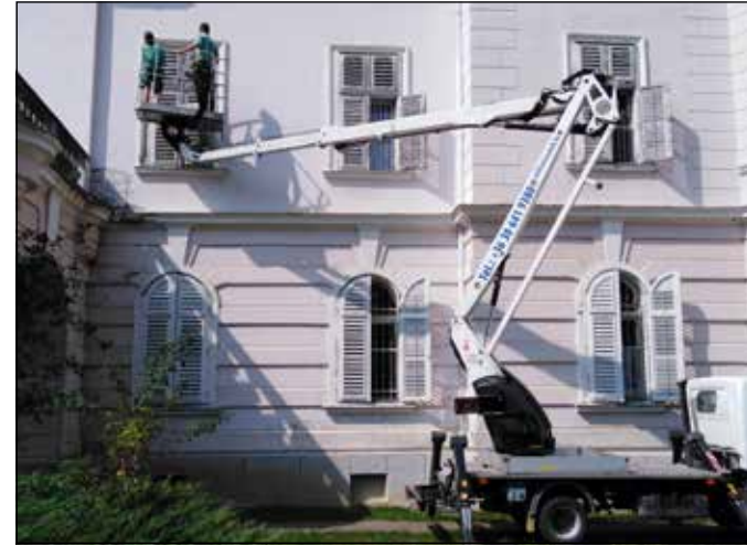
Ideiglenes szigetelés készítése a Rumi Kastély ablaktokjához
